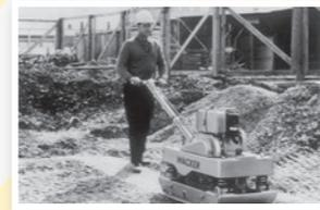
Erste reversierbare Vibrationsplatte von Wacker
