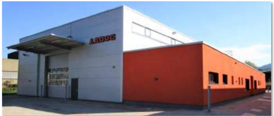
Werk 2 - Schwerpunkt Stahlbau und Lackierung
